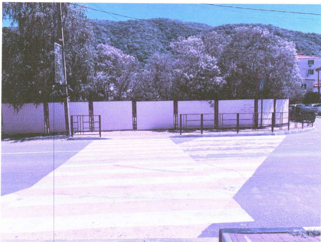
ФОТО № 14: Пешеходный переход от остановки к ДОУ
