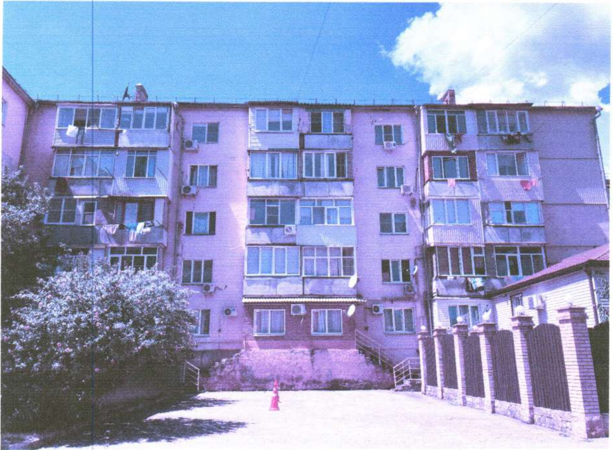
ФОТО № 11: Жилой дом по ул. Центральной, напротив въезда в хозяйственный блок
