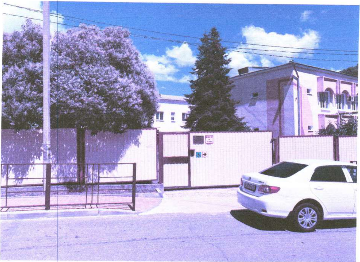
ФОТО № 1: Главный вход на территорию ДОУ
